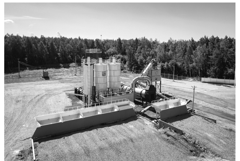
Новый завод выпускает 1200 тон асфальта в смену
